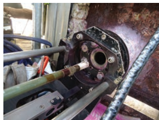
Automatisierte Vor-Ort-Reparatur von Stutzen
