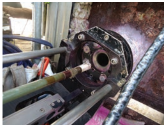
Reparación automatizada de tubuladuras en campo
