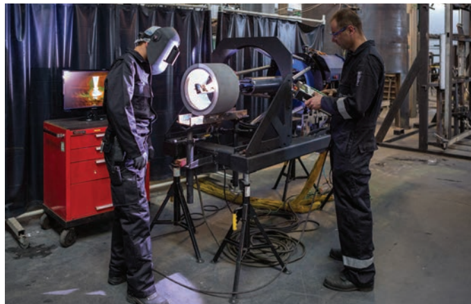
Rechargement d'un piquage avec Nozzlefuse 624
