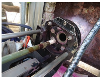
Réparation In Situ d'un piquage de réacteur
