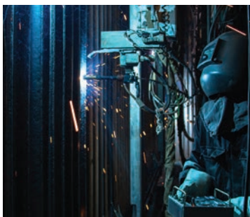
Reparación en una caldera de incineración
