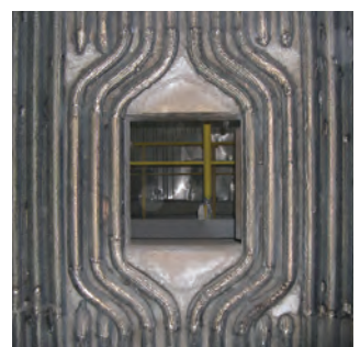
Plattierte Membranwand mit Ausbiegungen
