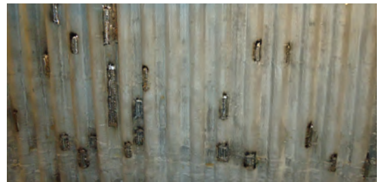
Punktuelle Ausbesserungen an einer alten 625 Auftragsschweißschicht
