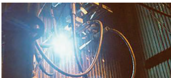
Vor-Ort Reparatur an einem Kessel zur Rückgewinnung von Schwarzlauge
