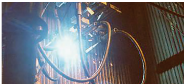
Reparación sobre el terreno en una caldera de recuperación de lejías negras
