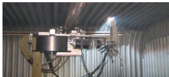
Si l'épaisseur résiduelle des tubes est trop faible, il convient de réaliser un rechargement acier afin de rétablir l'épaisseur nominale
