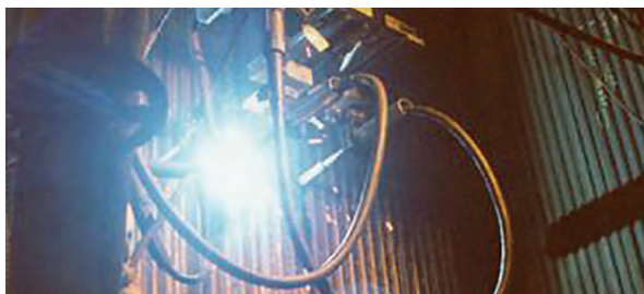
Réparation d'une chaudière à récupération de liqueur noire sur site
