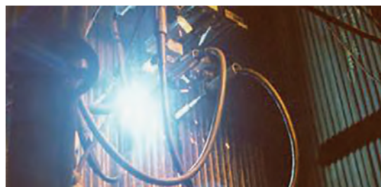
Riparazione in campo di una caldaia a recupero di liquor nero
