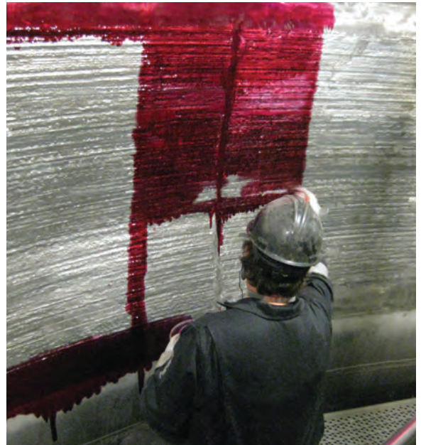
Inspección PT del recargue con soldadura
