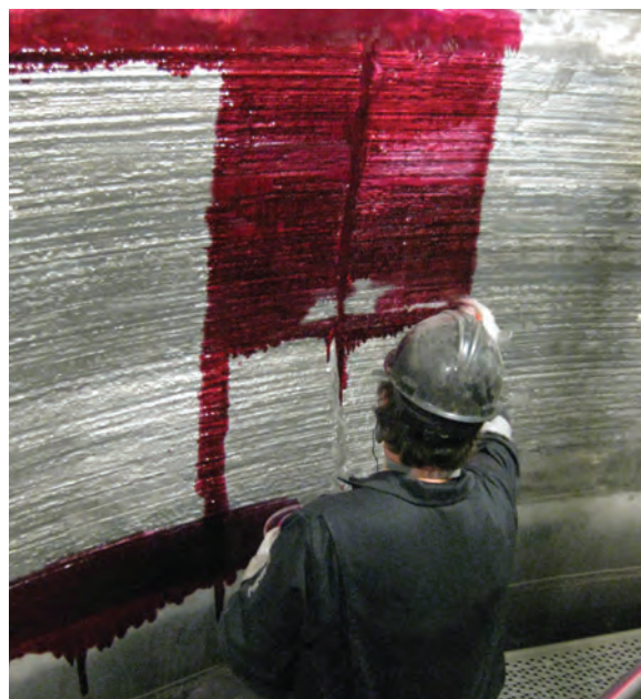
Ispezione PT del rivestimento di saldatura
