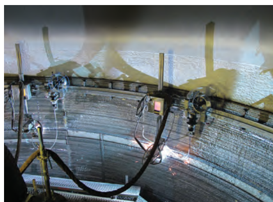
Riparto di saldatura automatica con il processo Unifuse
