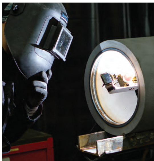
WSI offre una soluzione completamente automatica per il rivestimento e la riparazione interna degli ugelli in una gamma che va dai 2 ai 24 pollici
